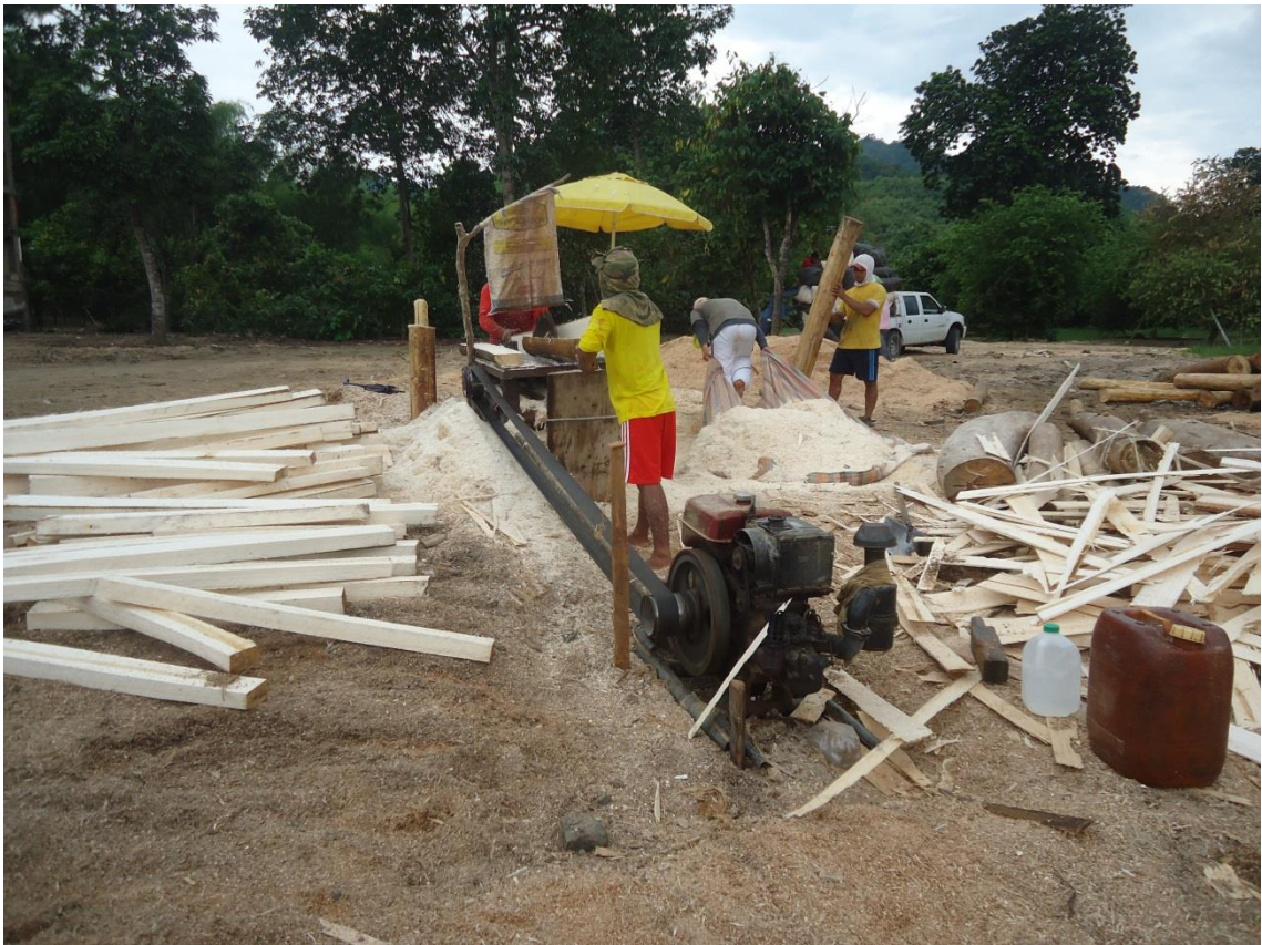
Imagen No. 16. Limpieza de los desechos proporcionados por el corte.
