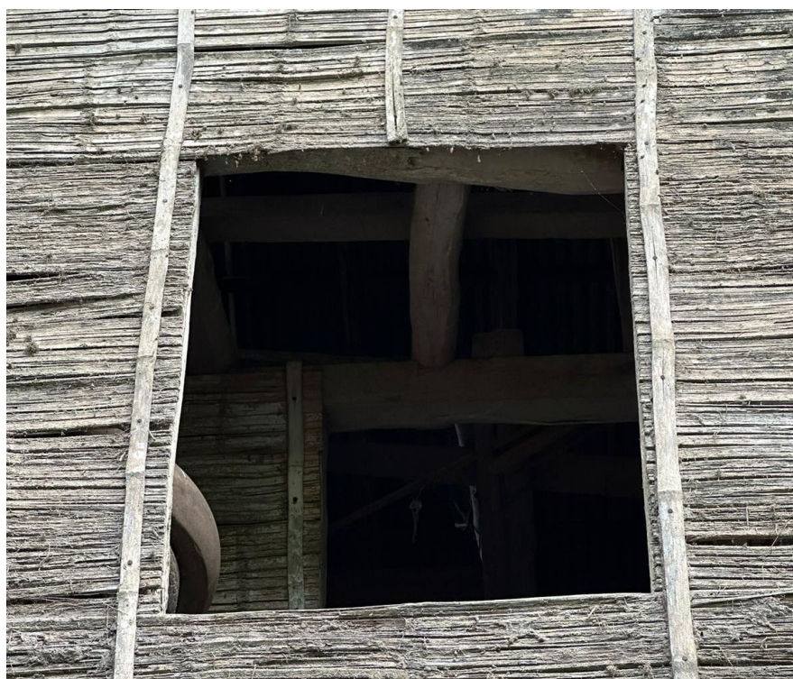
Anexo 6, Ventanas hechas de madera y caña guadua, material propio de la zona
