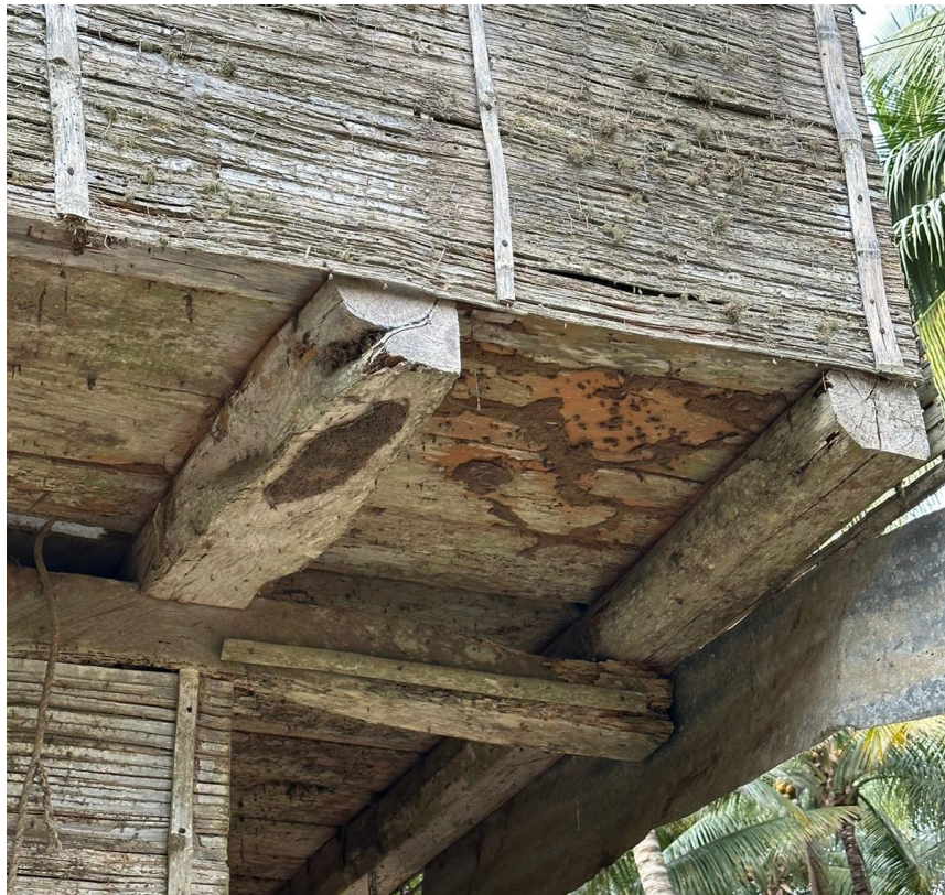
Anexo 4, Ensamblajes de Madera dentro y fuera del inmueble
