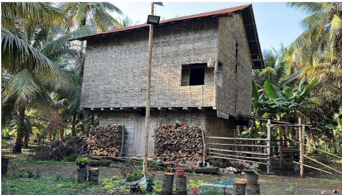
Anexo 1, Vista Frontal de la Vivienda Patrimonial
