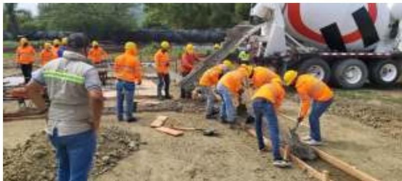
**Ilustración 21.** Fundición de cimentación mediante mixer. Proceso constructivo del edificio del Área de Ciencias de la Salud de la USGP. Fotografía tomada por autores de esta investigación.
