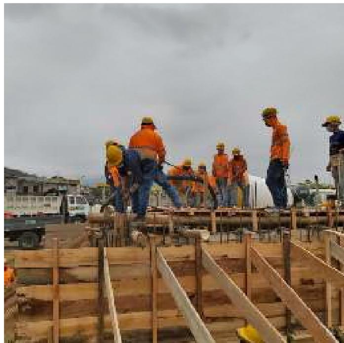
**Ilustración 24.** Fundición de losa superior mediante mixer. Proceso constructivo del edificio del Área de Ciencias de la Salud de la USGP. Fotografía tomada por autores de esta investigación.
