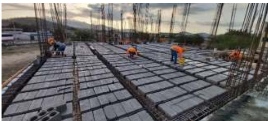
**Ilustración 22.** Armado de losa superior. Proceso constructivo del edificio del Área de Ciencias de la Salud de la USGP. Fotografía tomada por autores de esta investigación.
