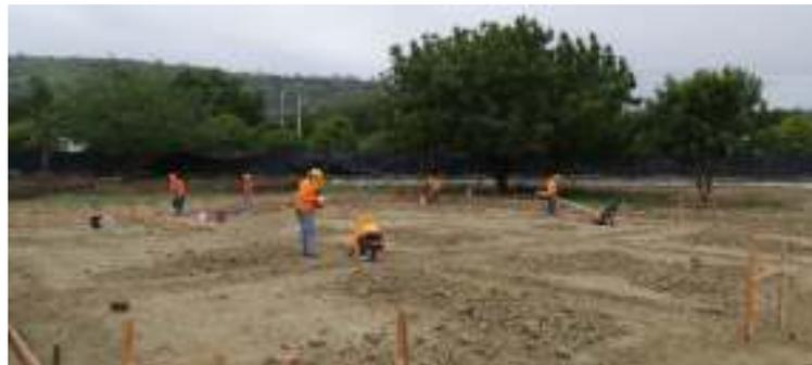
**Ilustración 19.** Replanteo y nivelación. Proceso constructivo del edificio del Área de Ciencias de la Salud de la USGP. Fotografía tomada por autores de esta investigación.
