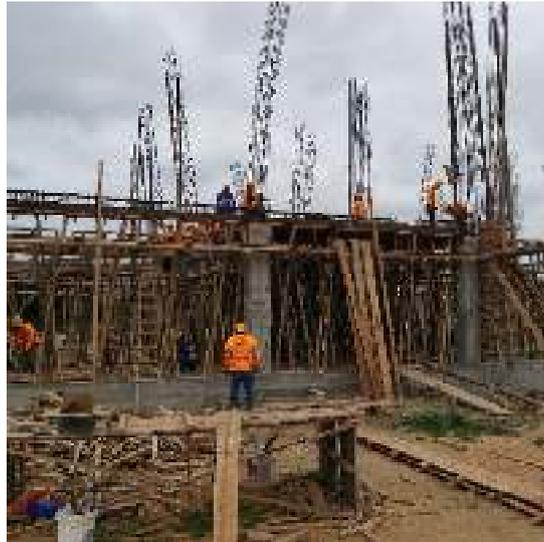
**Ilustración 23.** Armado de vigas superiores. Proceso constructivo del edificio del Área de Ciencias de la Salud de la USGP. Fotografía tomada por autores de esta investigación.
