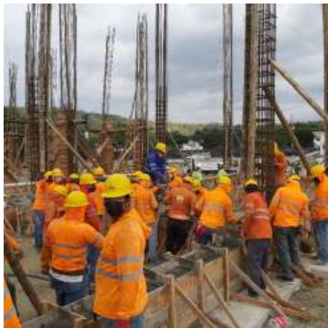
**Ilustración 26.** Fundición de cimentación mediante mixer. Proceso constructivo del edificio del Área de Ciencias de la Salud de la USGP. Fotografía tomada por autores de esta investigación.
