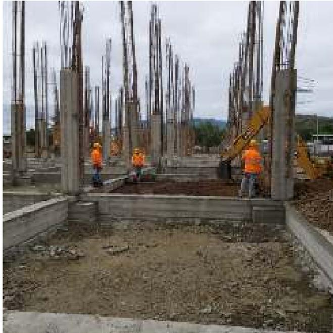
**Ilustración 25.** Relleno de suelo para contrapeso. Proceso constructivo del edificio del Área de Ciencias de la Salud de la USGP. Fotografía tomada por autores de esta investigación.
