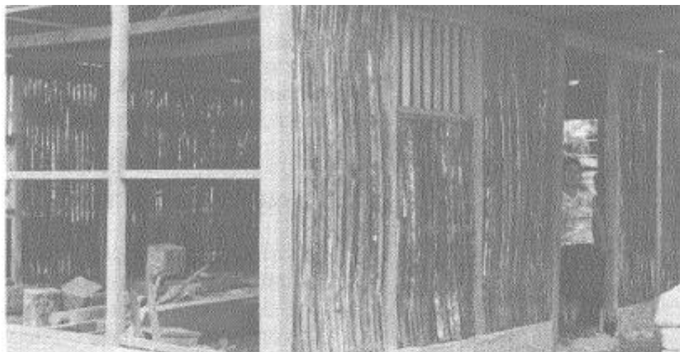
Figura 7. Construcción con quincha tradicional
