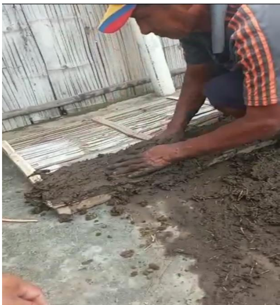
Figura 22 Proceso de relleno manual
