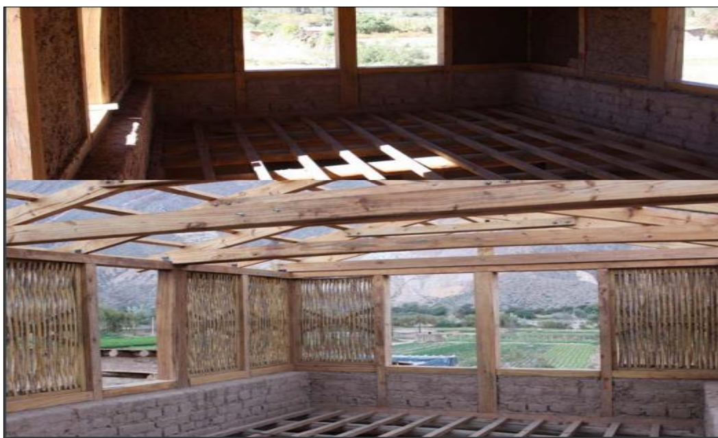
Figura 3. Quincha con estructura mixta
