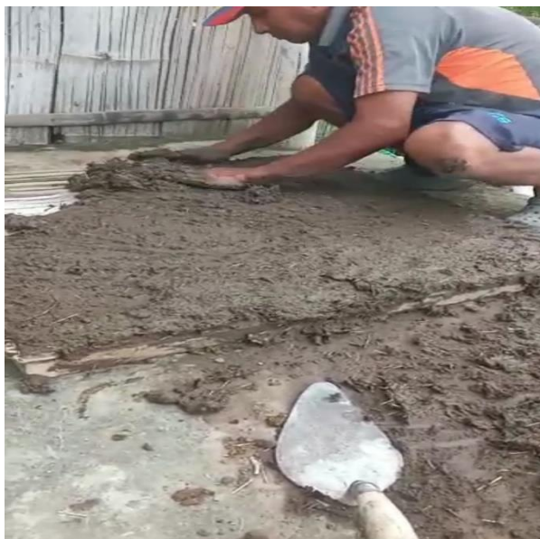
Figura 23 Revestimiento de toda la superficie
