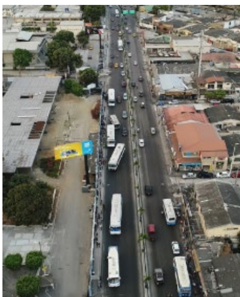
Figura 6: Avenida Delta antes de la intervención
