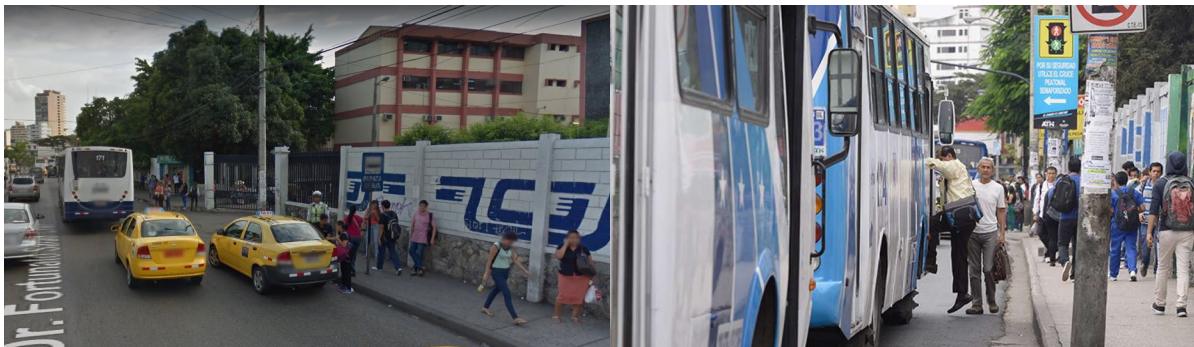
Figura 33: Paradero de bus previo a la intervención de la avenida
