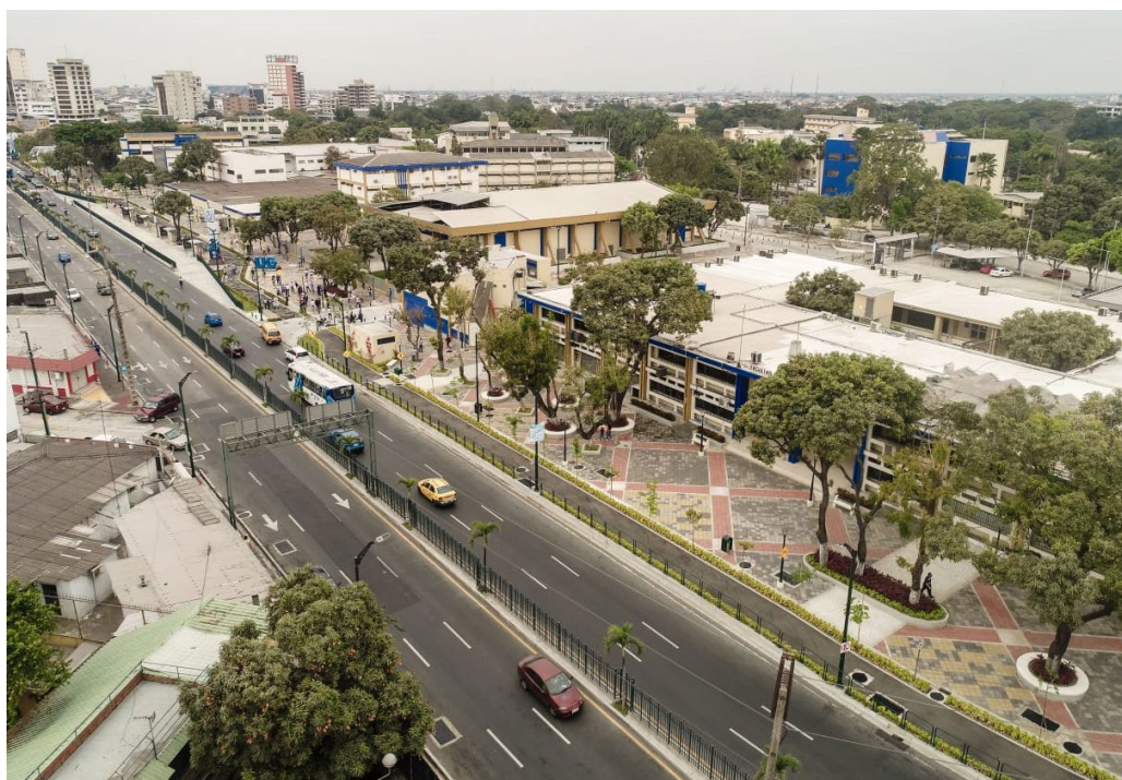
Figura 17: Avenida Delta después de la intervención
