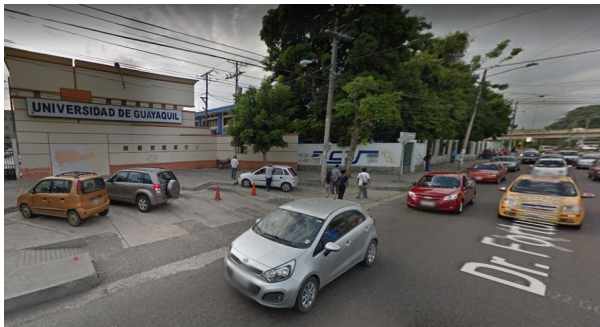
Figura 9: Berma de parqueo
