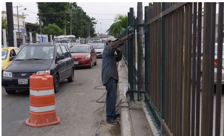
Figura 2: Instalación de reja en parte central de la Av. Delta
