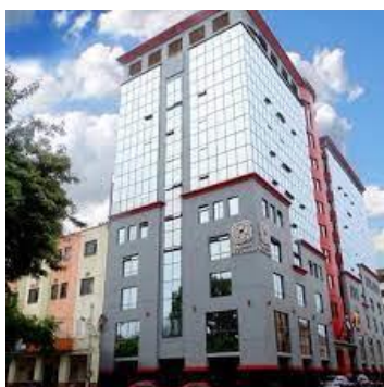
Edificio La Previsora
