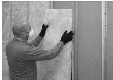
Nota. (Echeverria & Gonzalez, 2021). Aplicación de Lana de vidrio en rollo (Fotografía) Tomado de Aislamania. <https://cutt.ly/eCMmTbT>
