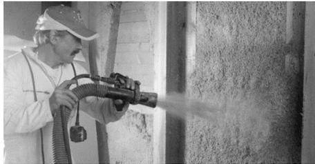
Nota. Thermofloc (2015). Aplicación de espuma celulósica proyectada (Fotografía) Tomado de Sistemas de aislamientos inteligentes Thermofloc. <https://cutt.ly/NCMbvUI>
