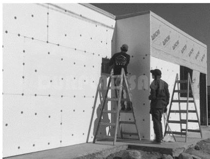
Nota. Durplack. Aplicación de Poliestireno Expandible Standard (Fotografía) Tomado de Durplack. <https://cutt.ly/0CMUOdB>
