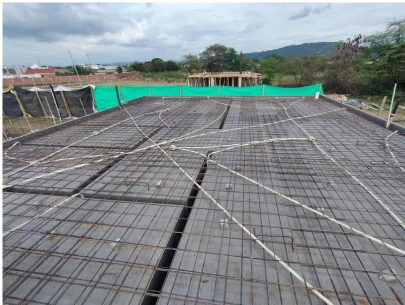
*Nota.* [Fotografía]. Tubería de PVC de 1/2 pulgada colocada sobre las formaletas horizontales.
