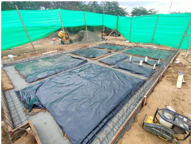
*Nota.* [Fotografía]. Se colocó plástico negro (polietileno) sobre el material de relleno para posterior fundido de concreto. Elaborado por autores del estudio de caso. (2022)
