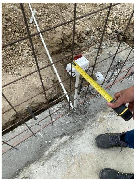
*Nota.* Malla electrosoldada colocada desde el contrapiso, traslapada con barras de acero fundidas desde la cimentación. Se observa la instalación de un punto de tomacorriente previo
