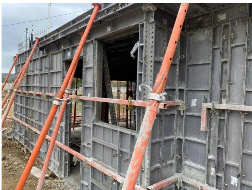
*Nota.* Las formaletas se encuentran sostenidas por puntales metálicos diagonales y tubos metálicos horizontales longitudinales de refuerzo [Fotografía]. Elaborado por autores del estudio de caso. (2022)
