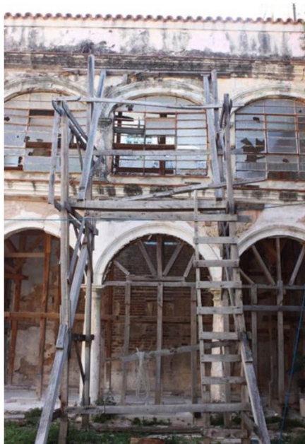
Figura 14 “Estado de conservación y fallos estructurales en el primer claustro” Fuente: Paradiso, Garuglieri & Ferrarini, 2019
