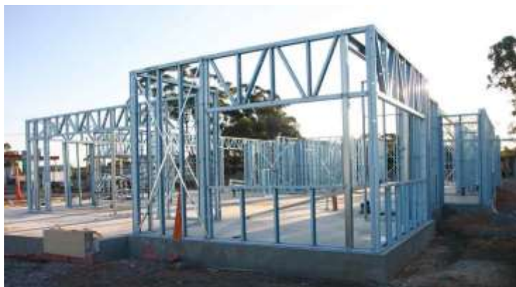
Figura 1 Estructura de Steel Framing
