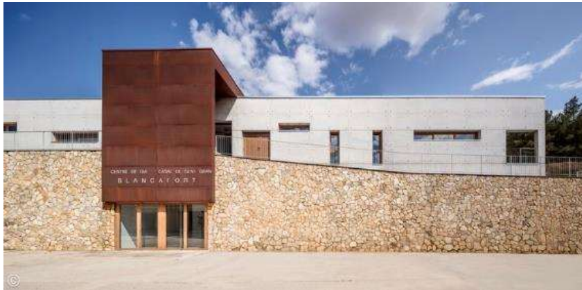
Figura 6: Fachada del Centro de día y hogar para mayores de Blancafort Adaptado de “Centre de dia i casal de gent gran de Blancafort / Guillem Carrera”, por Arch Daily, 2016.
