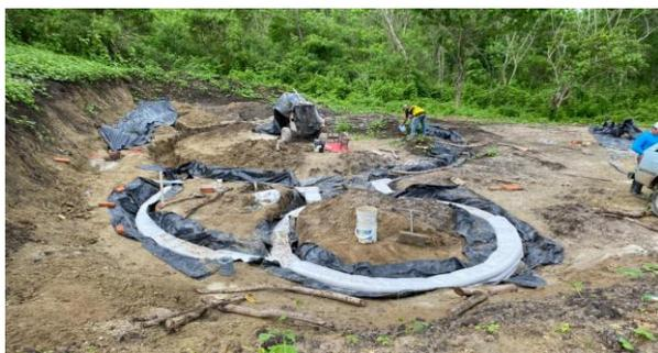
1. Una vez relleno el saco, se coloca sobre la lona de impermeabilización y se procede al apisonamiento del mismo.
