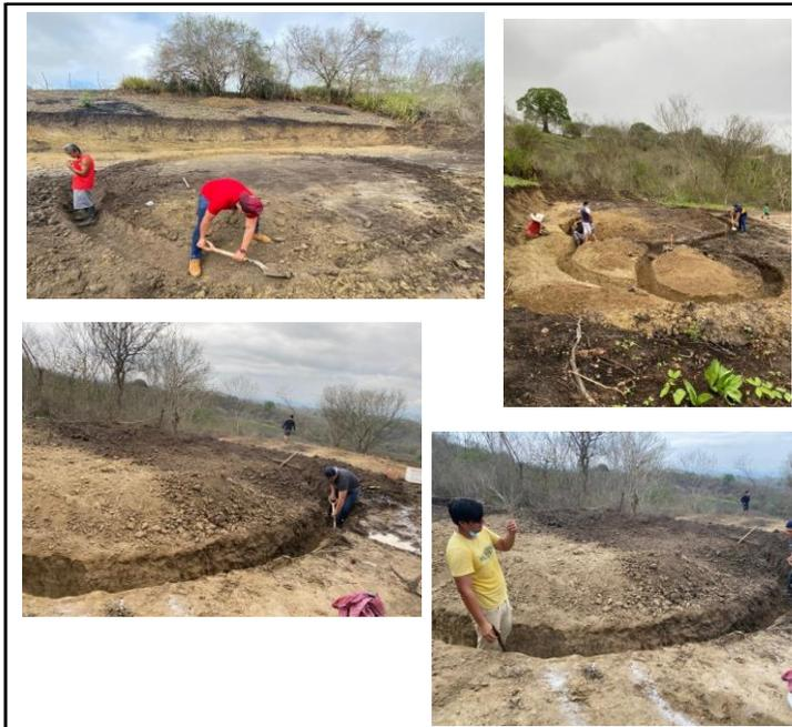
Finalizado el replanteo del terreno, se procedió a la excavación de la zanja de 60 cm para la cimentación en donde se acento el espacio habitable
