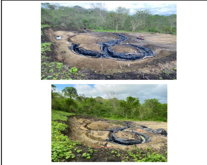
Después del relleno de la zanja para la nivelación, se llevo a cabo la colocación del material impermealizante, el cual evita que el saco de polipropileno este en contacto directo con el agua permitiendo que este no sufra daños en su estructura.
