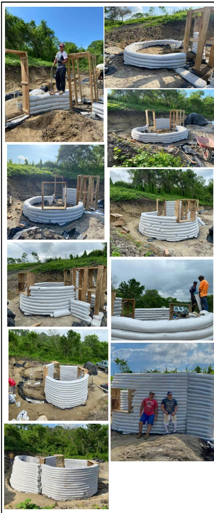
3. Mediante el uso de dos ejes principales, el eje horizontal y el eje vertical, se determina el nivel de los sacos y cuanto disminuye la circunferencia a medida que se avanza la construcción. Siguiendo estas directrices el espacio habitable va tomando forma. Por las lluvias se atrasaron los trabajos, ya que la accesibilidad al terreno se vio afectada.
