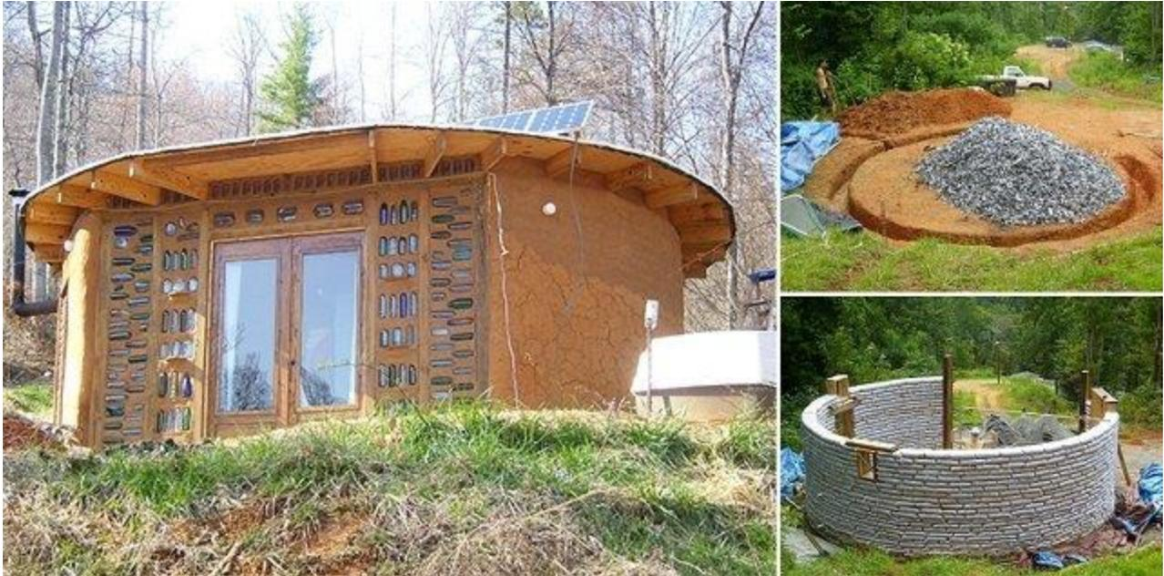
Nota. Vivienda desarrollada con la técnica del Superadobe. Tomada del sitio *web*: *ConstruyePaís*, *noticiero de Arquitectura e Ingeniería*. *Construcción paso a paso de una casa con sacos de tierra*. <https://construyenpais.com/construccion-paso-a-paso-de-una-casa-con-sacos-de-tierra/>
